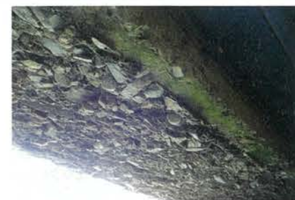
写真2 ■ RC床版を下から見た様子
