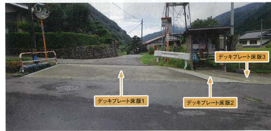
写真3 ■ 橋軸方向から見た橋梁
